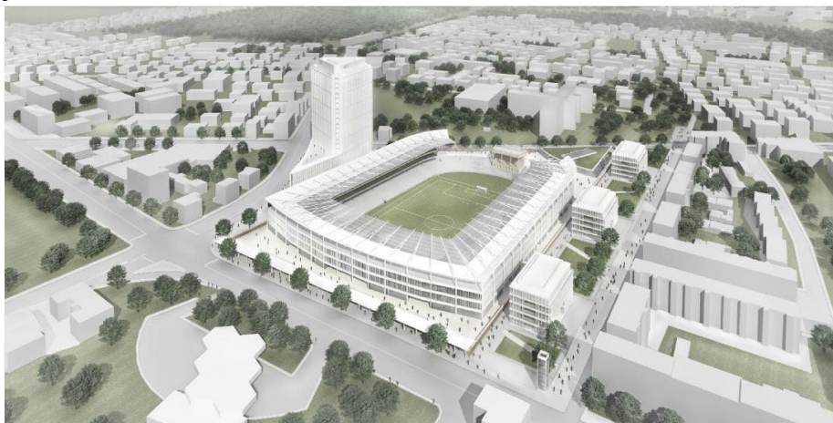
Končno stanje po zaključeni 8. fazi gradnje
