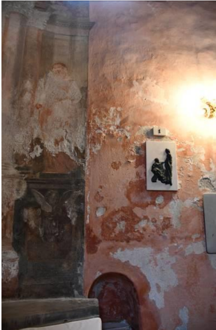
Z vlago in solmi obremenjene stene, predvsem na severni strani cerkve
