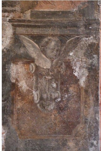
Z vlago in solmi obremenjene stene, predvsem na severni strani cerkve
