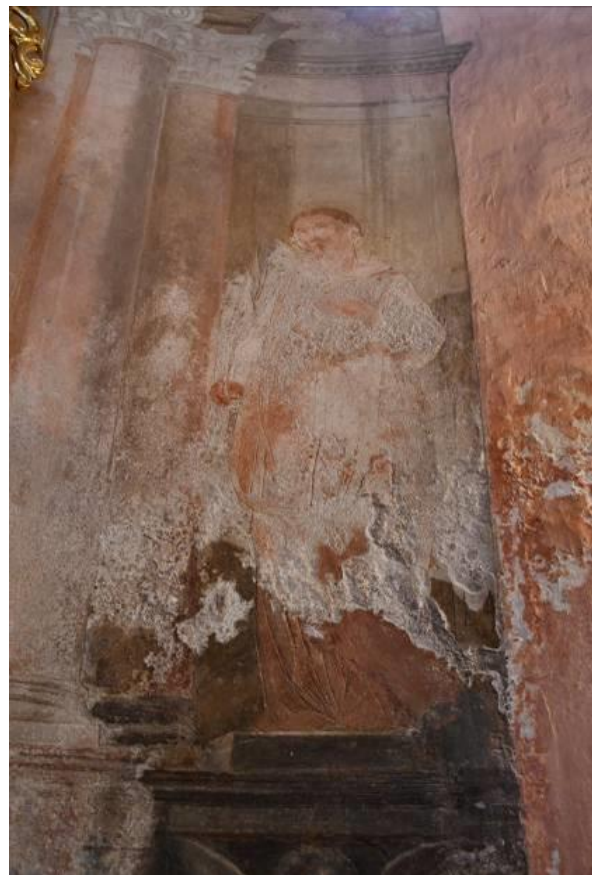
Desni prizor – stenska slika; močno poškodovana zaradi delovanja vlage in soli
