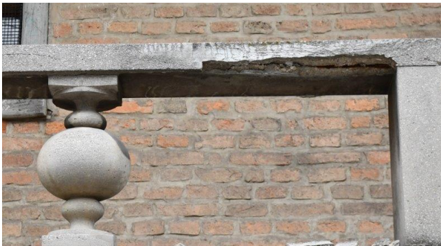
Poškodba balustrade ograje
