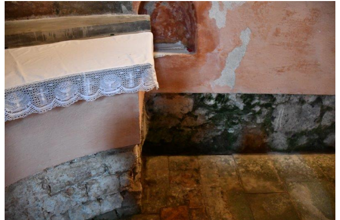
Poškodba severne stene
