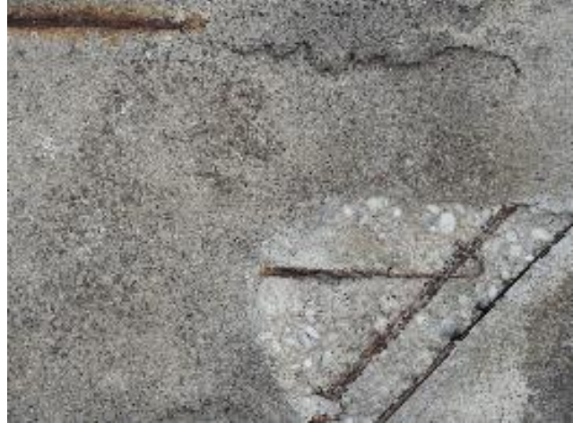
Vidna notranja kovinska armatura na nadstrešku ob zvoniku
