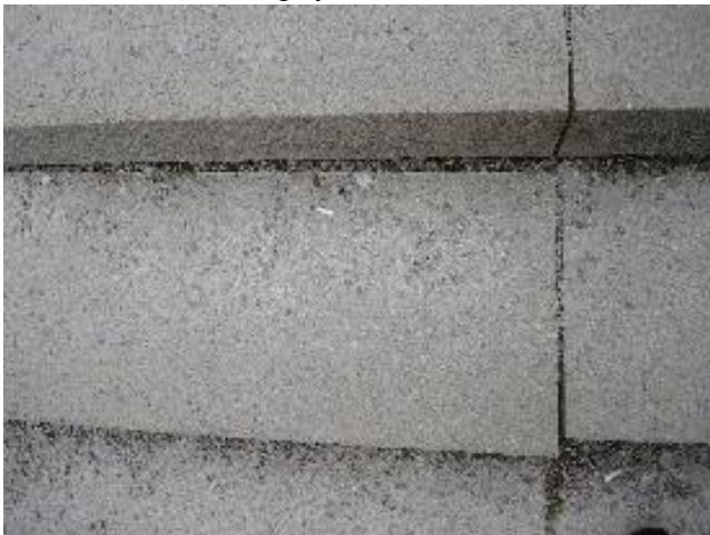
Detajl stopnišča –dislocirane stopnice
