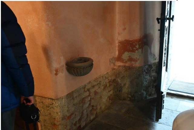
Poškodba ob vhodu na SV strani zidu
