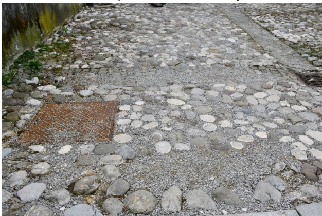
Poškodbe tlaka na podestu stopnic
