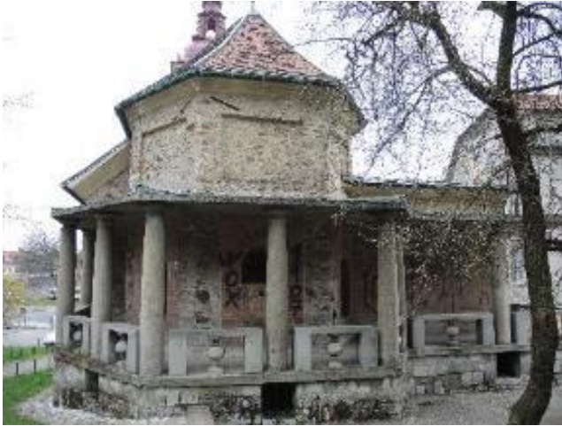
Zahodna fasada, poškodbe z grafiti
