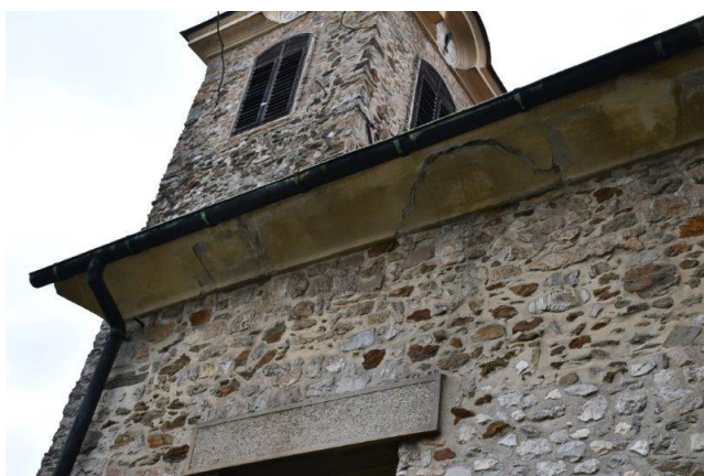
Severa fasada, poškodba napušča
