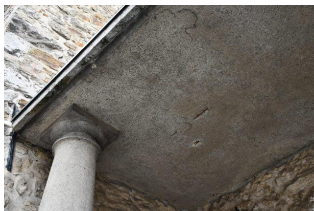
Južna fasada, poškodbe nadstreška
