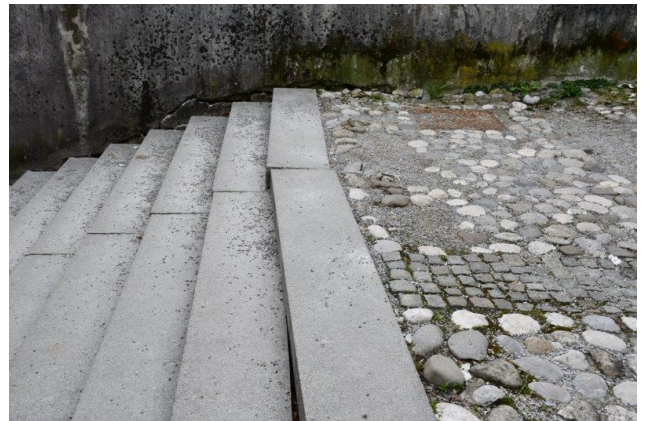
Poškodbe, premiki stopnic in neustrezna sanacija tlaka
