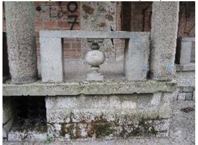
Stebri in prosto stoječi elementi s številnimi mehanskimi poškodbami
