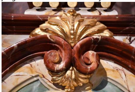
Poškodbe izletne luknjice lesnih insektov
