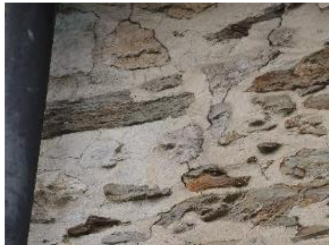
Razpoke vzdolž stikov na vzhodni fasadi
