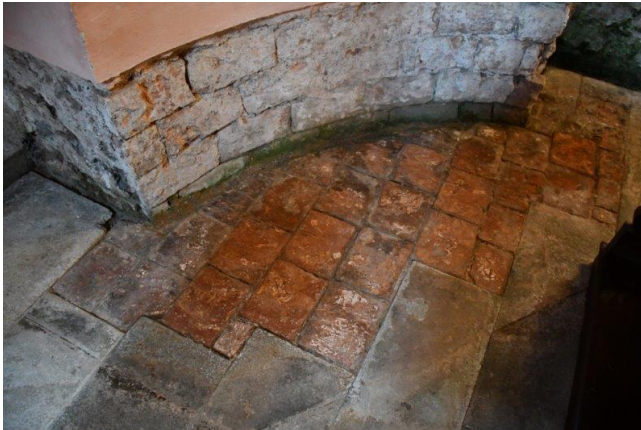
Poškodba tal ob severni steni v stiku med kamnom in opeko
