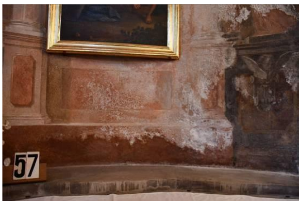
Spodnji del oltarja; desna stran v slabem stanju zaradi delovanja vlage in soli
