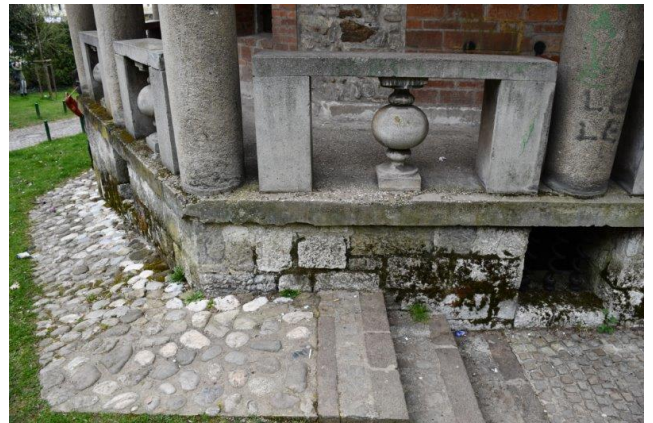
Biološki dejavniki propadanja na zahodnem delu fasade
