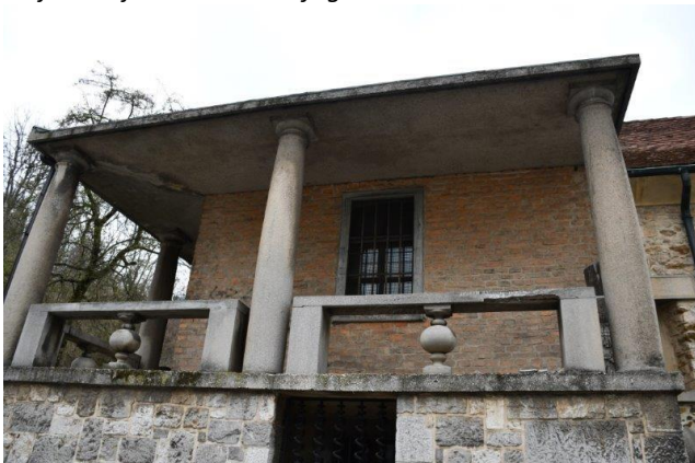
Poškodbe ograje iz umetnega kamna na južni fasadi
