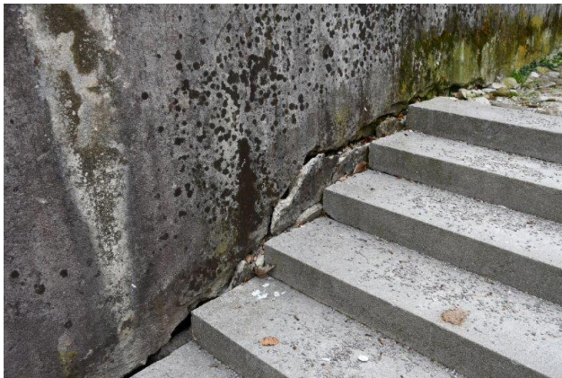
Poškodbe zidu ob stopnišču z biološkimi dejavniki
