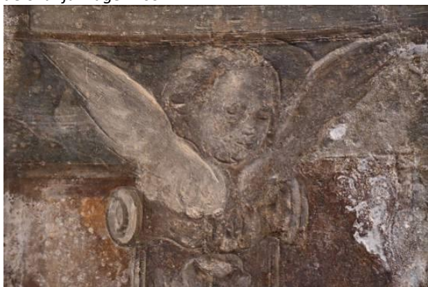
Desna stran oltarja, spodaj; prisotne poškodbe
