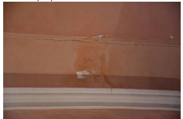
Vidne globlje razpoke na stropu in steni
