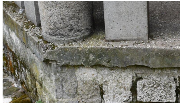
Poškodba zaključka nad kamnitim zidom pod lopo
