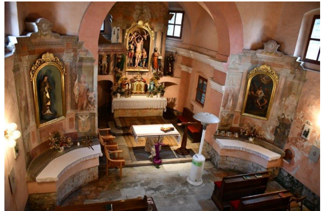
Pogled s kora na poškodbe zaradi vlage
