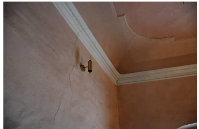
Globlja razpoka, ki teče po steni in se nadaljuje na strop ter čez stropno poslikavo
