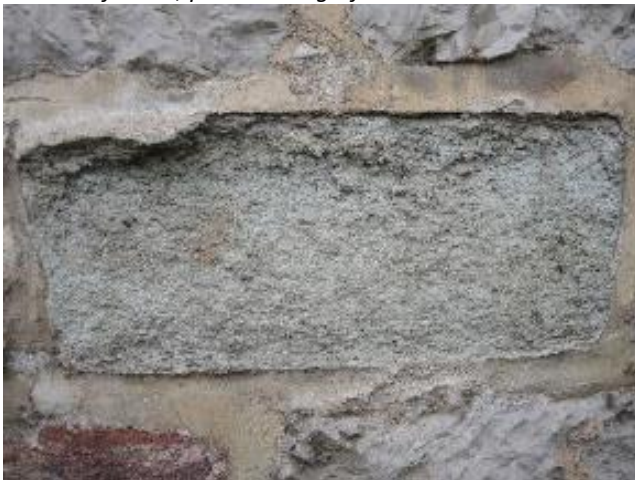
Vzhodna fasada, detajl elementa iz tufa, že zelo preperel in bolj ohranjene cementne fuge
